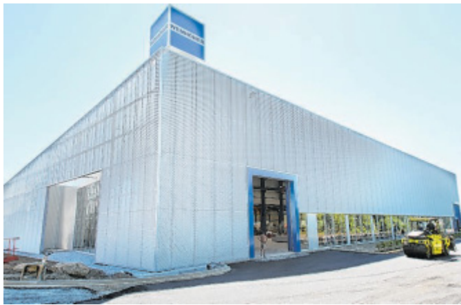
Fast fertig: Mitte Juli ist die Einweihung geplant, erst vorgestern wurde der blaue Wemhöner-Kubus montiert.
