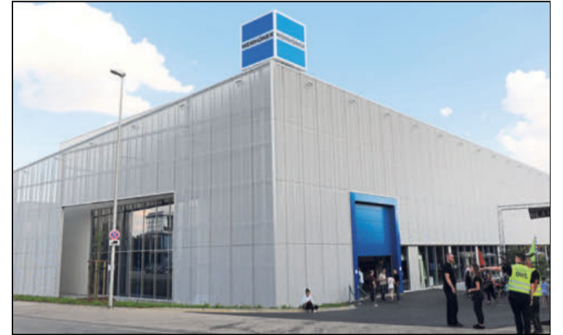
Vier Millionen Euro hat der Neubau an der Planckstraße gekostet. In der Sonne glänzte am Freitag die Fassade aus Streckmetall.
