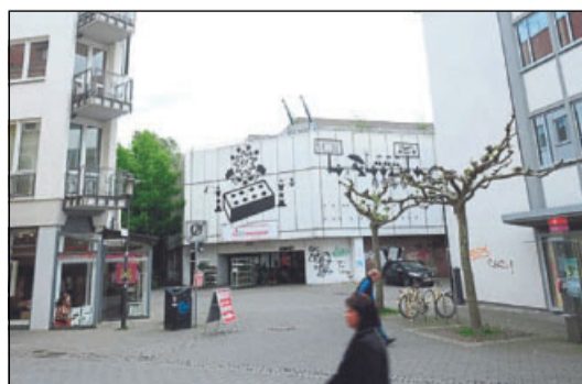
Heute geht's los: Die Teilabriss-Arbeiten am alten Kaufhof-Gebäude beginnen. Foto: Winde
