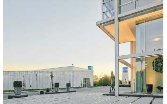
Ein architektonisches Juwel: Die im vergangenen Jahr eingeweihte neue Produktionsstätte von Wemhöner.
